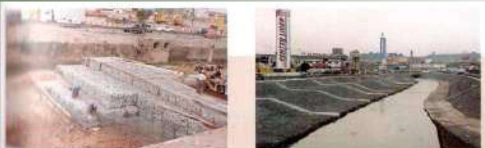
*Foto 2.16 - Soleiras em execução (em gabião "caixa") e calha do rio Aricanduva (em gabião "colchão") (2002)*
